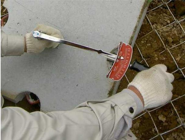
写真-4 トルクレンチ締付状況
