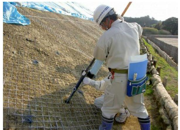
写真-3 ジオアンカー打設状況
