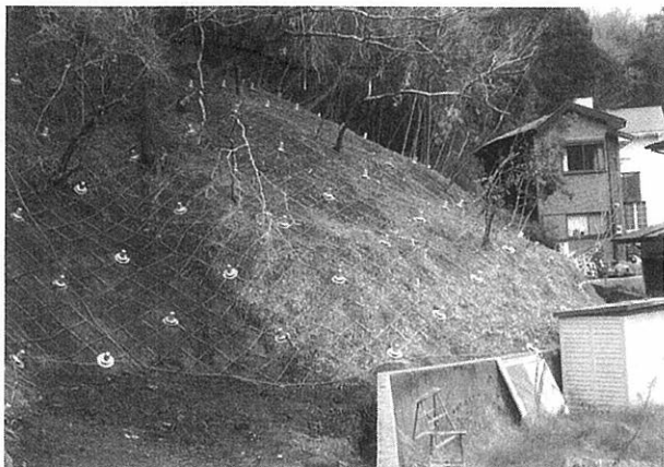
写真-4 対策工施工後の状況 (常盤地区)
