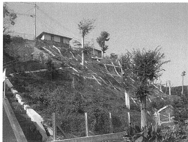
写真-5 対策工施工後の状況 (戸室 A 地区)
