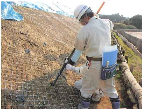
写真-3 ジオアンカー打設状況 (人力)
