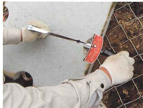
写真-4 トルクレンチ締付状況
