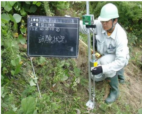
写真-1 SH 型貫入試験の状況
