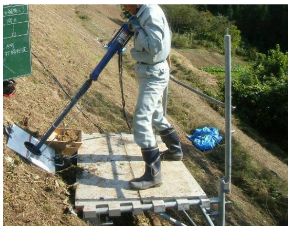
写真-4 ジオアンカーの施工状況
