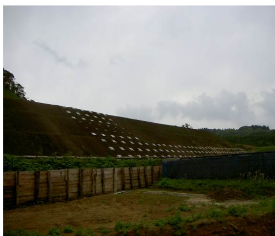
写真-5 施工完了 下段部を補強
