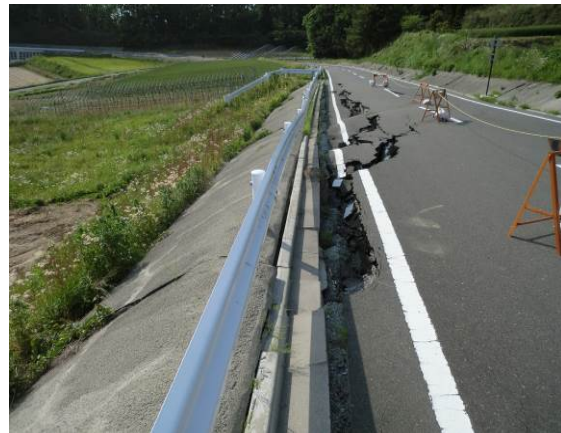
写真-11 無補強盛土箇所
