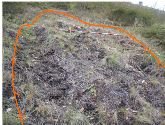
写真-9 No.140 付近の表層崩壊
