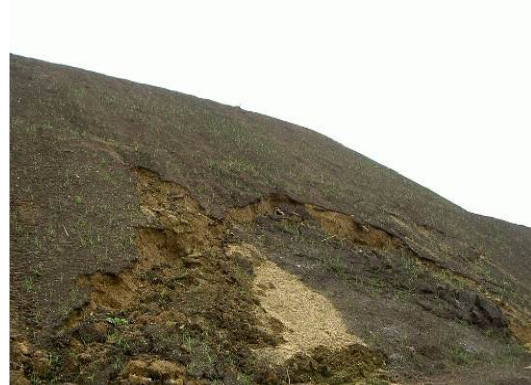
写真-7 2 段目の崩落状況
