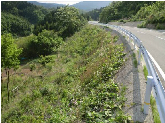
写真-10 ジオアンカー補強盛土箇所
