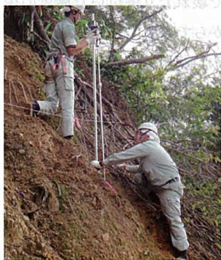
SH型貫入試験 施工風景(多点測定)
